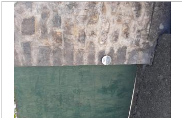
Repère posé sur le mur côté rue d'un particulier
