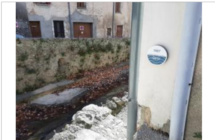
Repère posé sur une habitation
