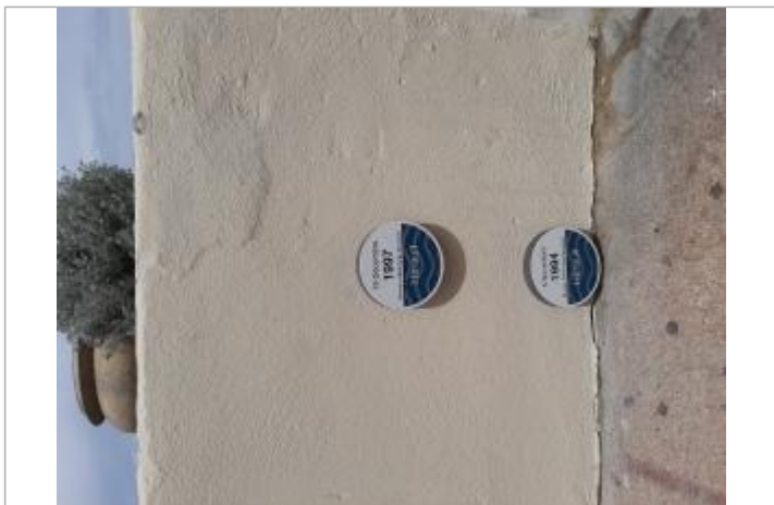
Repère posé sur un terre plein
