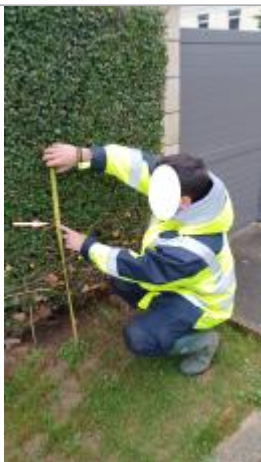
Laisse de crue à 78 cm/sol
