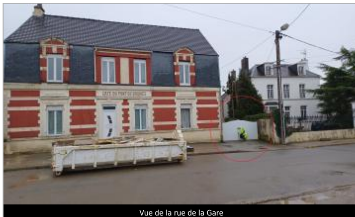
Vue de la rue de la Gare
