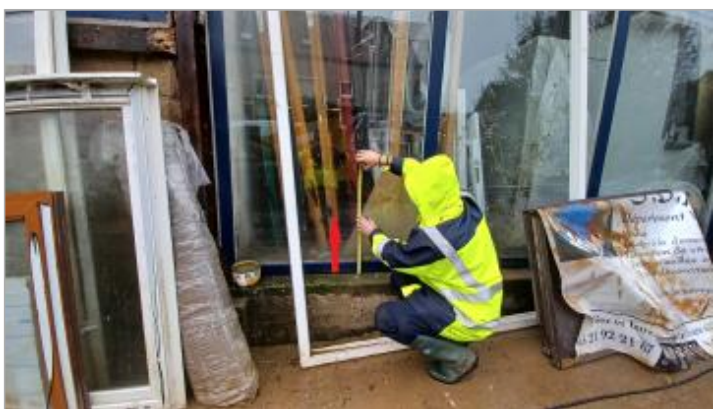
Laisse de crue à 41 cm/ rebord en béton situé au pied de la baie vitrée.
