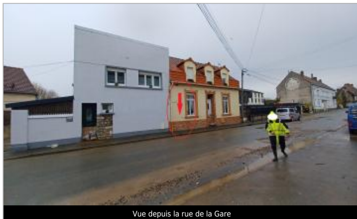
Vue depuis la rue de la Gare
