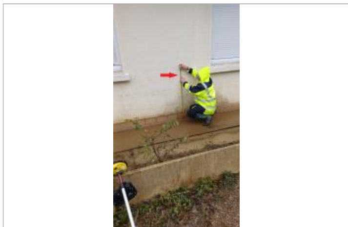
Laisse de crue à 86 cm/sol.
