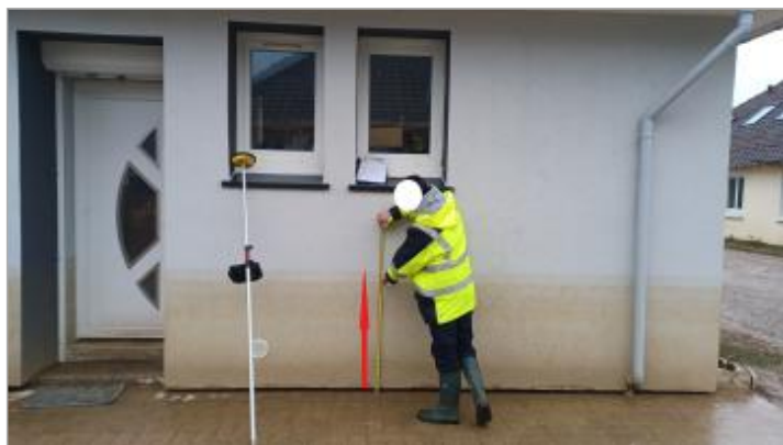
Laisse de crue à 94 cm/sol
