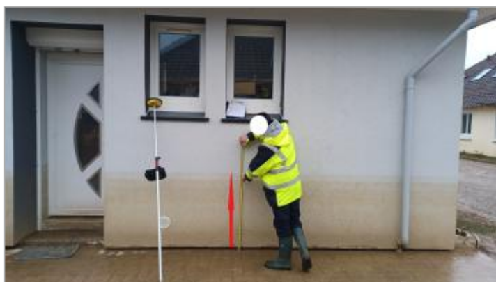
Laisse de crue à 94 cm/sol
