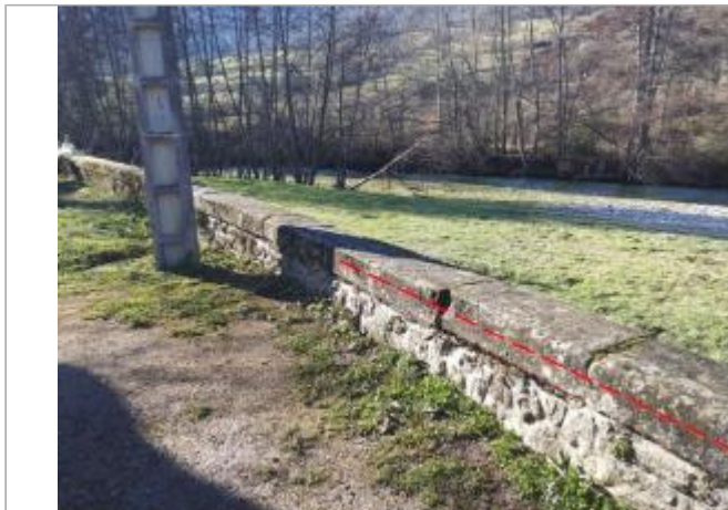
Vue du site © SURVEY
