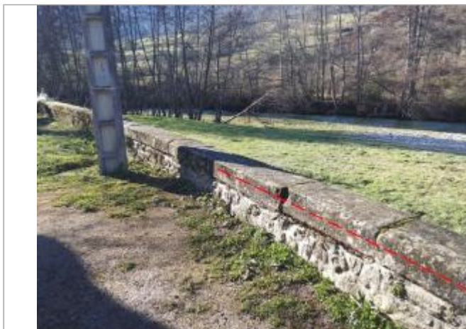
Vue du site © SURVEY
