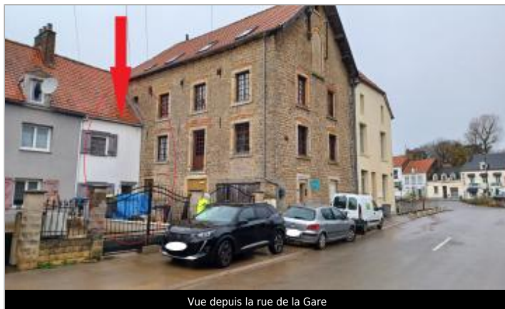
Vue depuis la rue de la Gare
