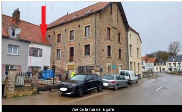
Vue de la rue de la gare
