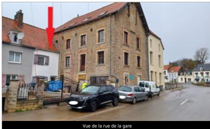
Vue de la rue de la gare
