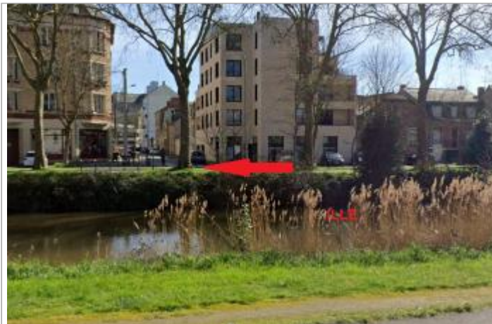
Berge rive gauche de l'Ille, Boulevard Chézy au niveau de la rue Robelin
