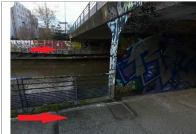
En aval du pont de la rue Saint-Malo (photo de Nicolas Texier - Electrik)
