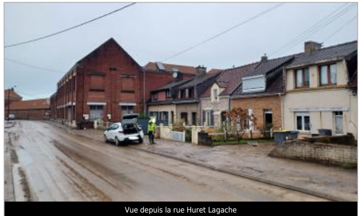
Vue depuis la rue Huret Lagache
