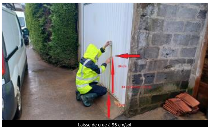
Laisse de crue à 96 cm/sol.
