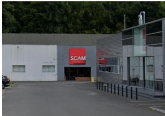
entrée principale des ateliers de la SCAM
