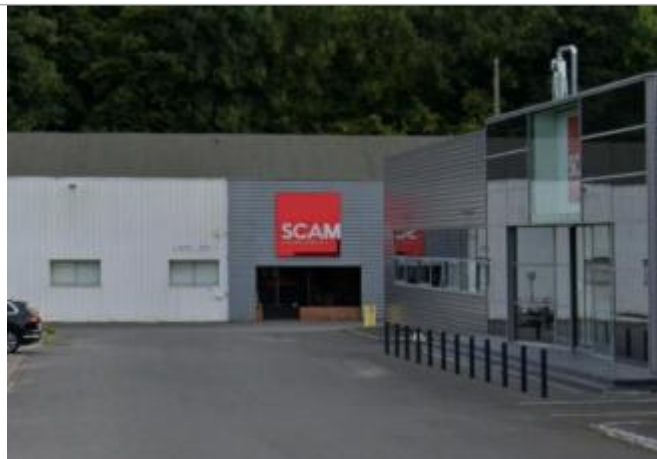
entrée principale des ateliers de la SCAM
