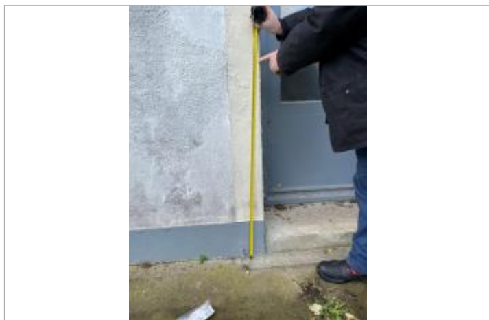
mur à cote de la porte d'accès à l'entrepôt
