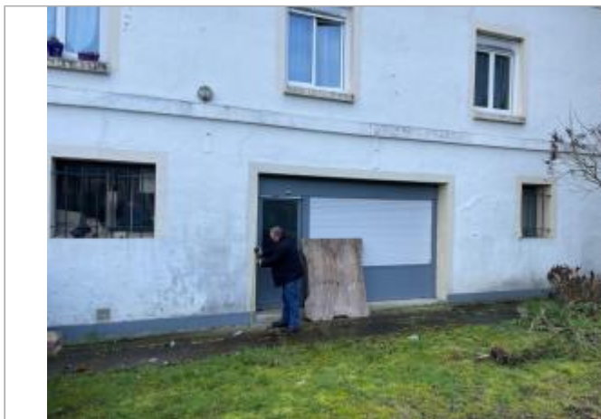
mur d'immeuble au droit de la porte
