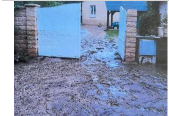
laisse de crue sur les portes et le pilier du portail
