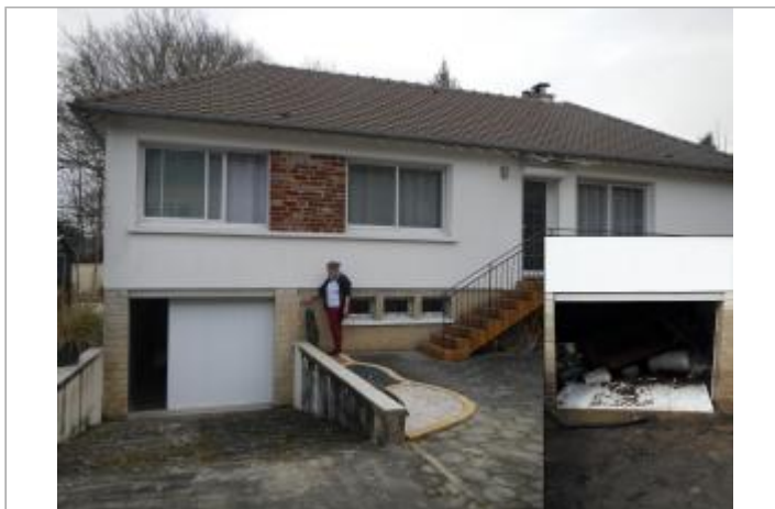
Maison d'habitation surélevée sur sous-sol - au droit du garage
