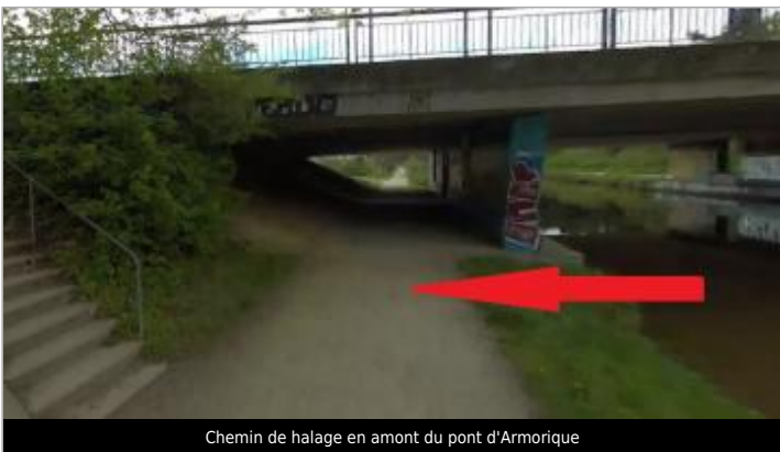
Chemin de halage en amont du pont d'Armorique
