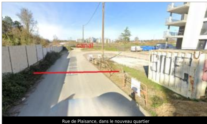
Rue de Plaisance, dans le nouveau quartier
