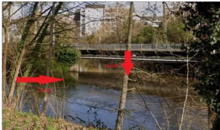
pont du boulevard de Chézy, pile en rive droite
