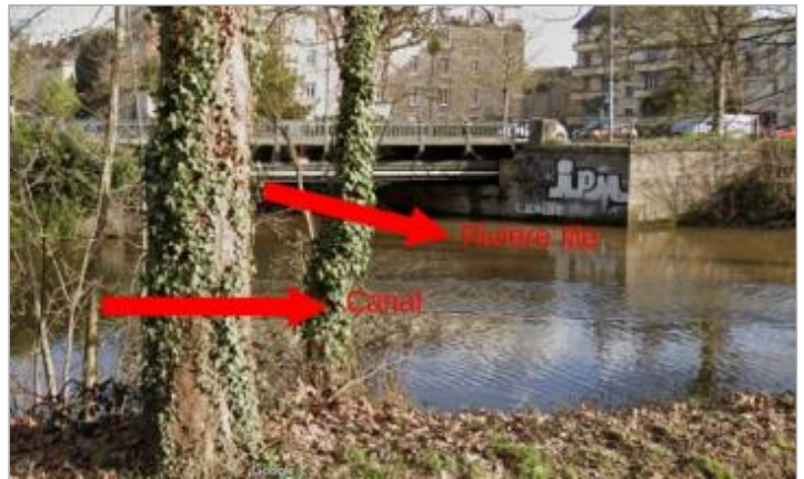
Pont boulevard de Chézy sur l'Ille à la confluence avec le canal d'Ille et Rance
