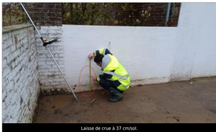
Laisse de crue à 37 cm/sol.
