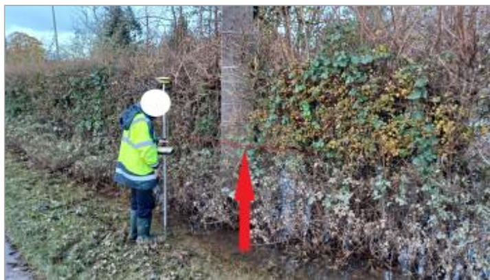
laisse de crue à 104 cm/sol
