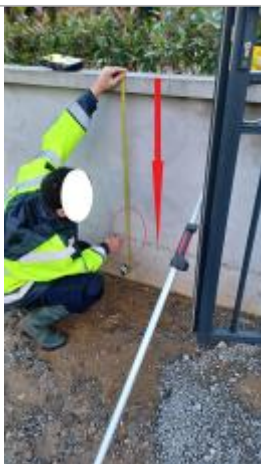
Laisse de crue à 89 cm/haut du muret.
