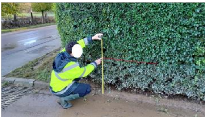
laisse de crue à 76 cm/sol
