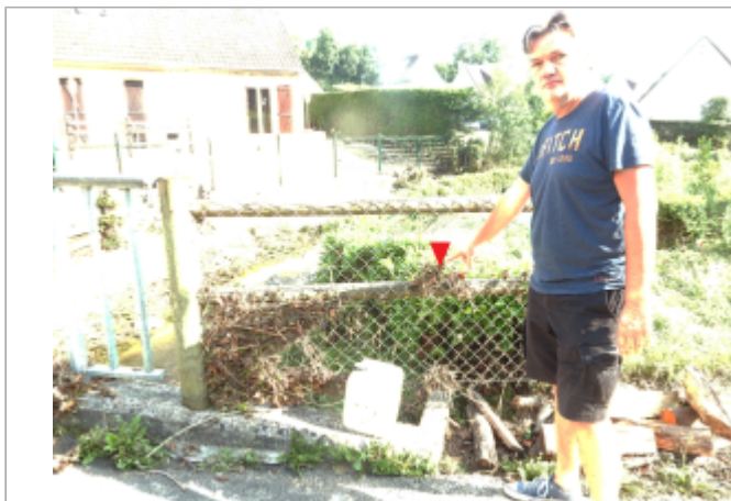
Grillage et balustrade du pont
