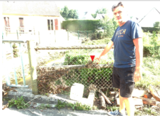
Grillage et balustrade du pont
