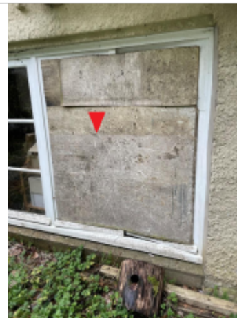
Façade ouest d'une dépendance
