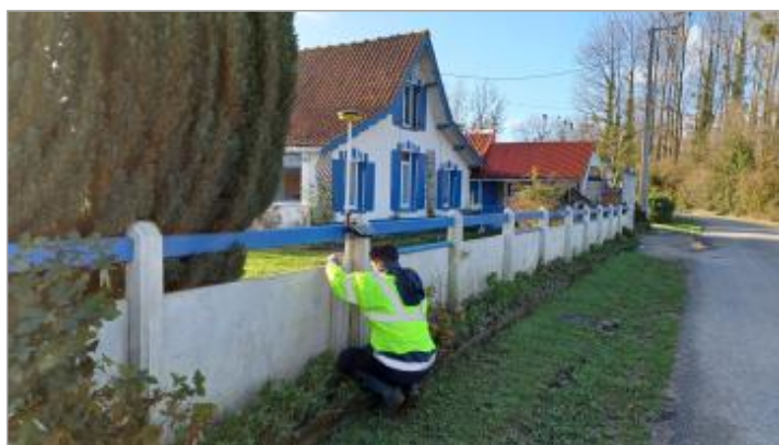
Laisse de crue sur le muret
