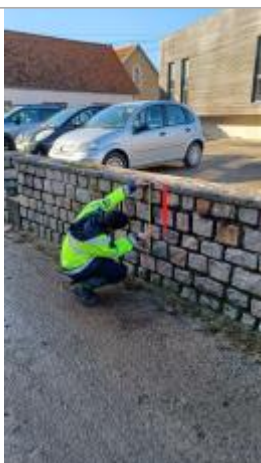
Laisse de crue à 47.5 cm du haut du muret.
