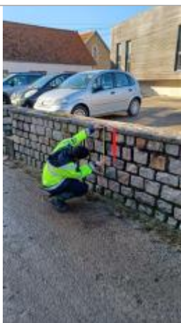
Laisse de crue à 47.5 cm du haut du muret.
