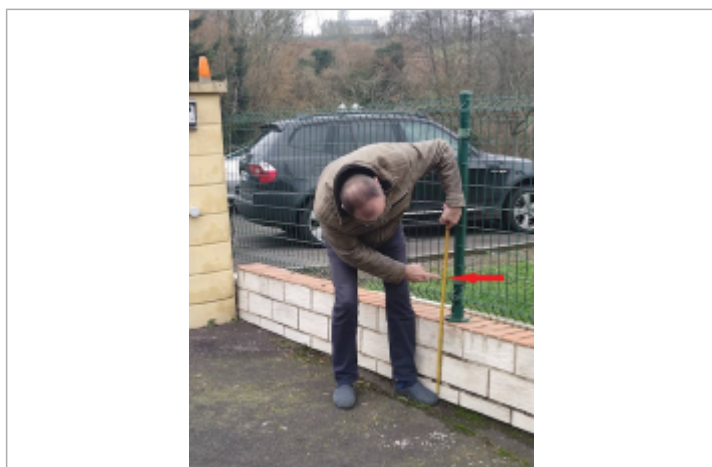
Au niveau du portail le niveau d'eau atteint était de 60 centimètres sur le poteau de la clôture.
