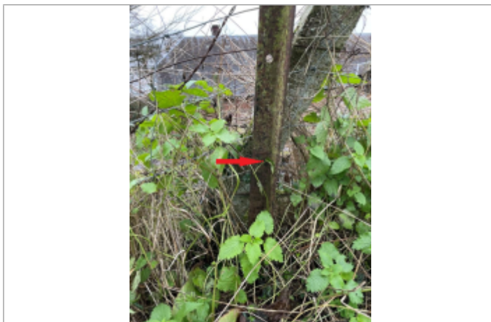
Détail sur poteau de clôture, vue proche.
