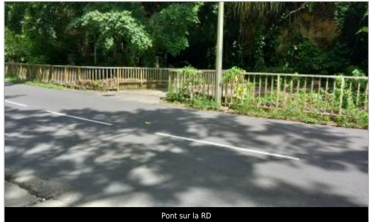
Pont sur la RD
