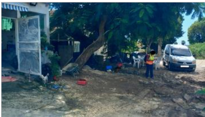
Passage de l'eau sous l'enrochement
