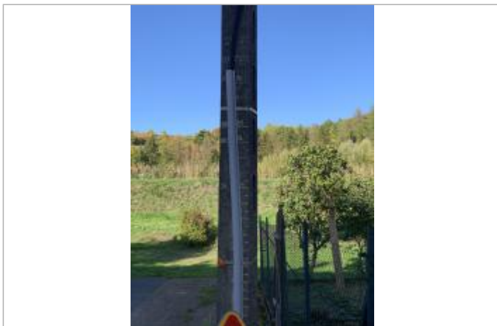
Repère de crues situé Ruelle du Gué - entre le N°24 et 26 Rue Jacquemin
