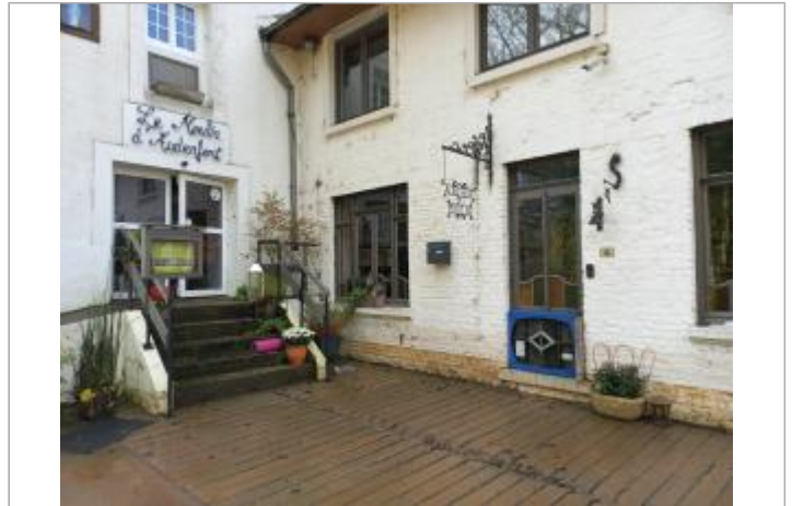
Laisse de crue
