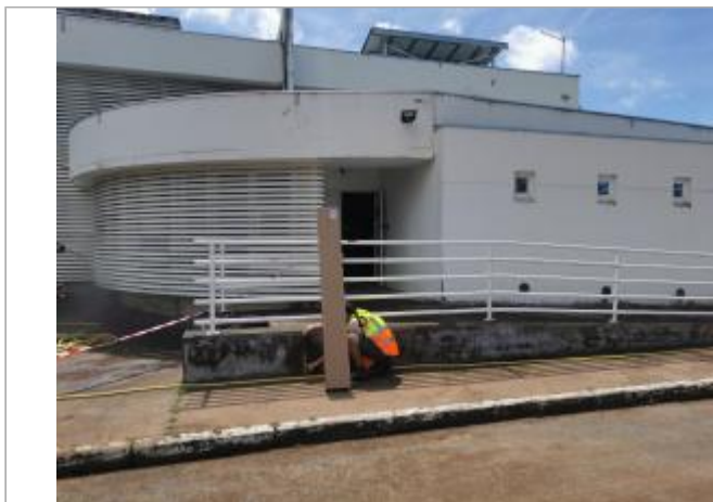
Entrée du personnel
