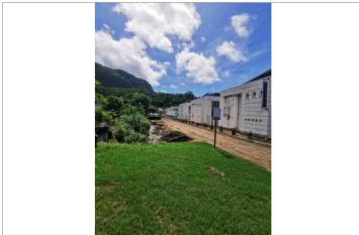
Emprise de zone inondée
