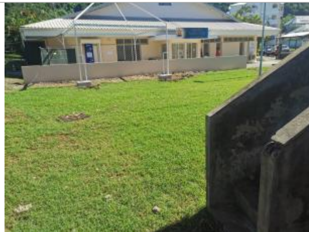
Vue d'ensemble accès escalier
