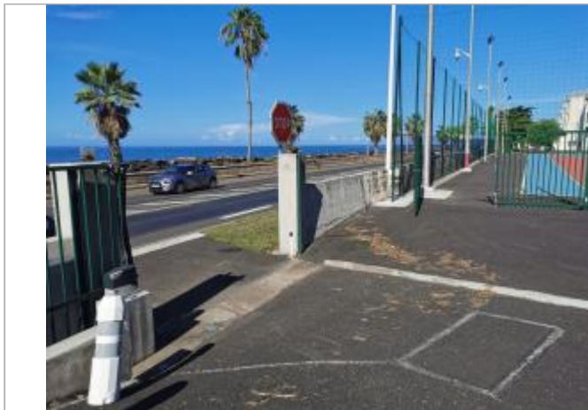
Vue de l'emprise inondée
