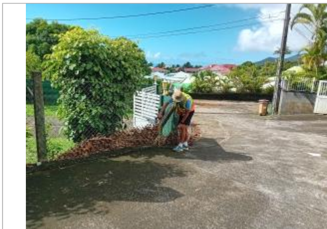
Grillage de clôture d'un bâti individuel
