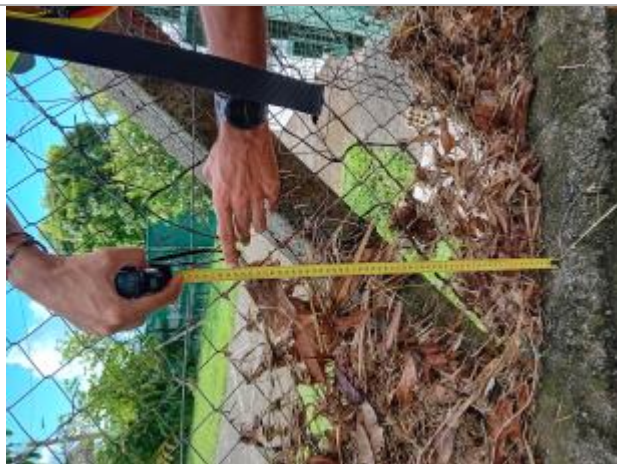
Dépôts de matières solides
