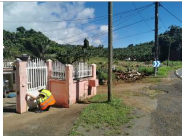
Mur de clôture d'une maison individuelle
