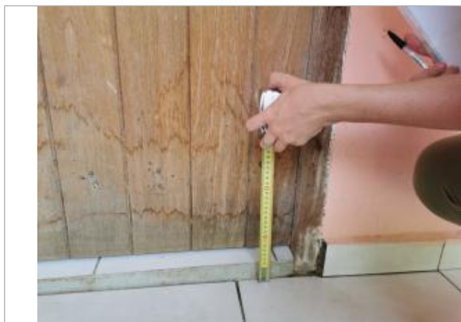
Dépôts de matières solides
